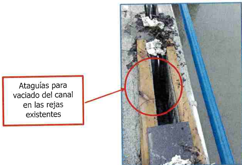
Fig. 5. Rejas existentes en canal de captación
