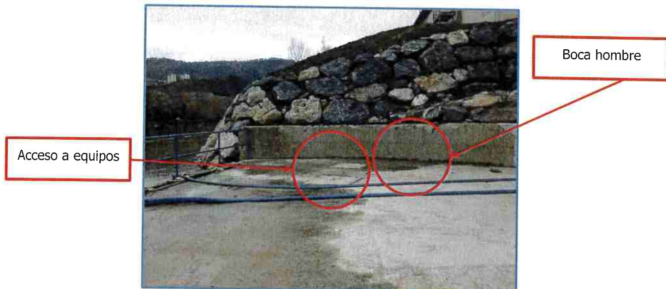
Fig. 4. Accesos al canal de captación
