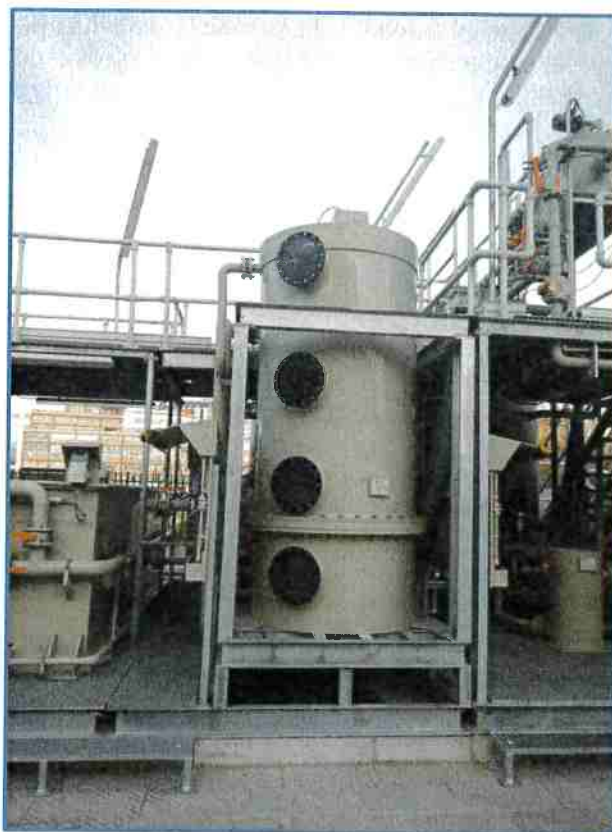
Fig. 14. Filtro de Arena
