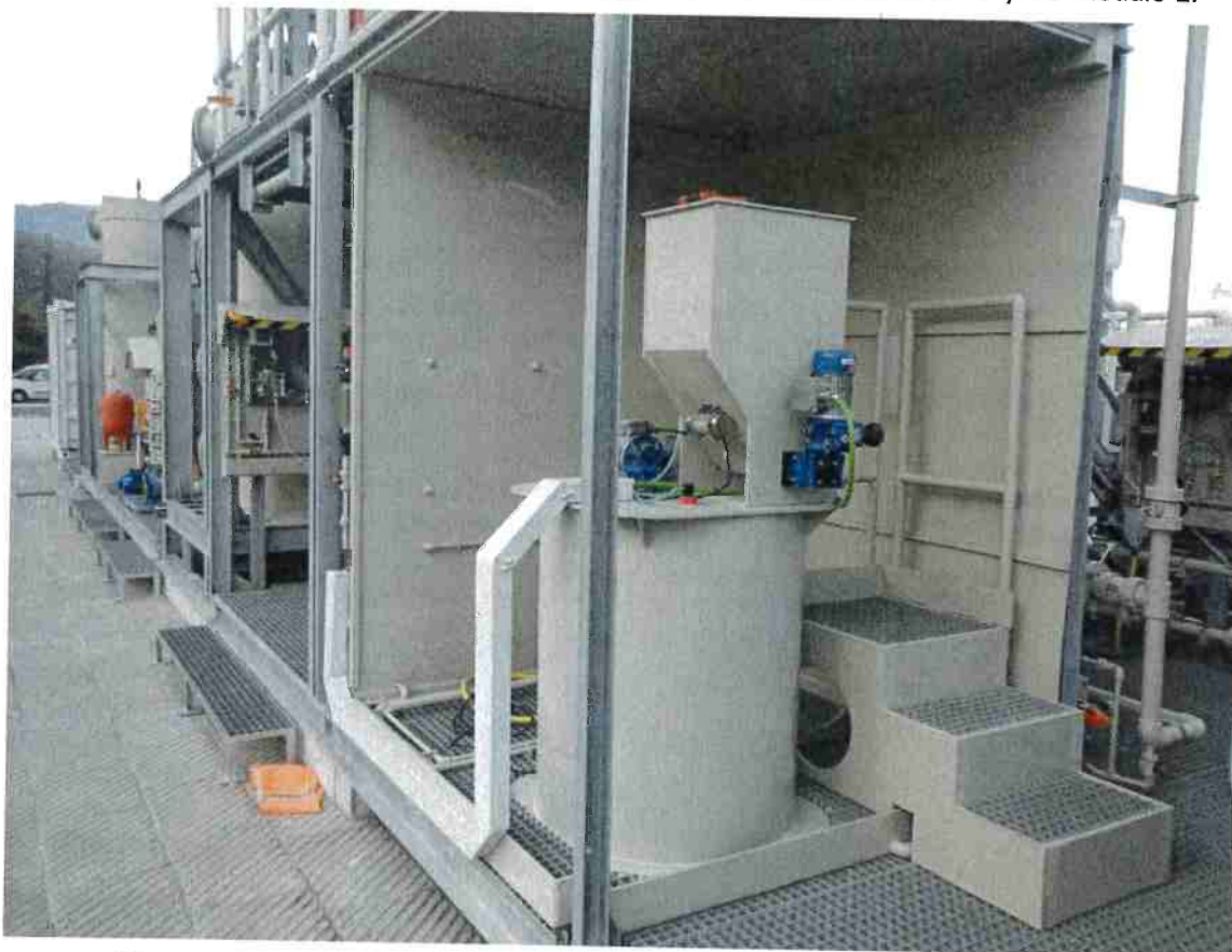
Fig. 20 Instalación de Almacenamiento y Preparación de Carbón Activo
