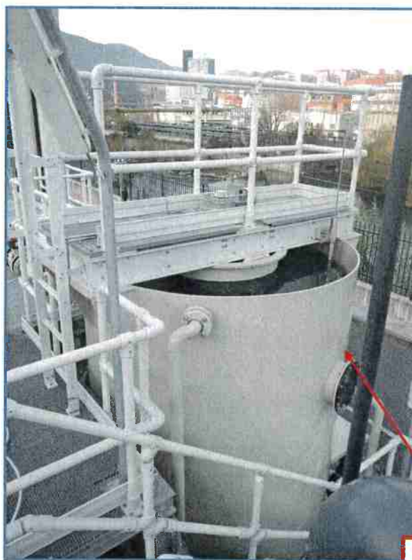
Fig. 13. Decantador Accentrifloc
