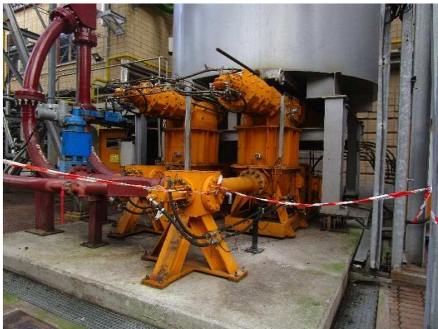
Lugar: EDAR GALINDO Edificio: I20-Alimentación de lodo Horno 3 Comentario: Vista general.
