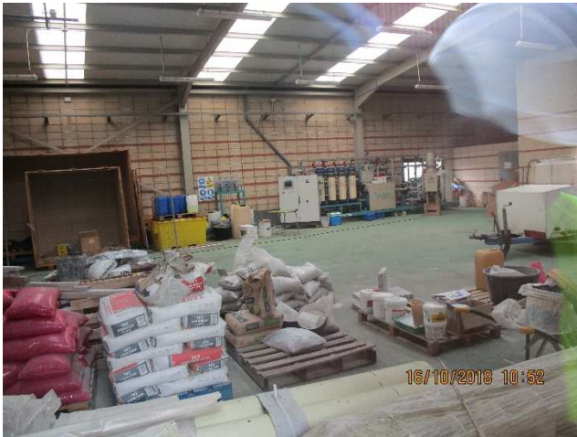
Lugar: EDAR GALINDO Edificio: E20 – Tratamiento terciario Comentario: Almacén polivalente.
