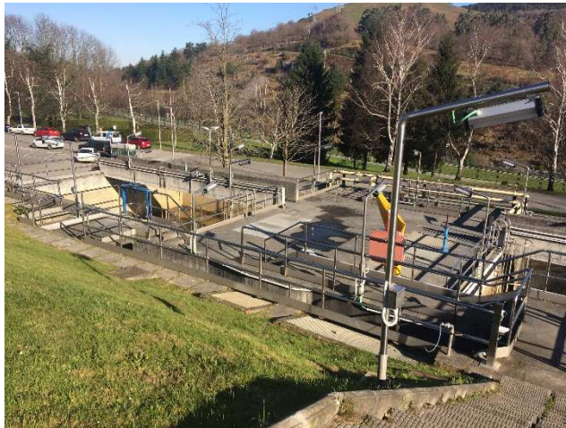
Lugar: EDAR GALINDO Edificio: Nº17 – Balsas de lodos Comentario: Vista general de la instalación.
