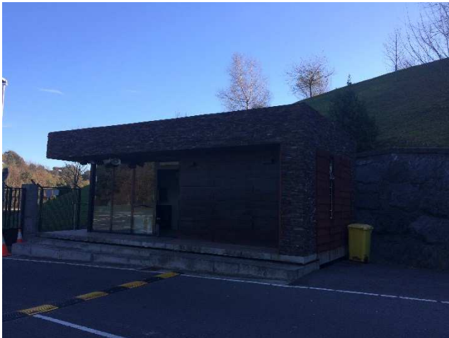
Lugar: ETAP VENTA ALTA Edificio: N°29 - Control de acceso Comentario: Vista general.
