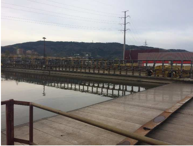
Lugar: EDAR GALINDO Edificio: I02 – Decantación primaria Comentario: Vista general.
