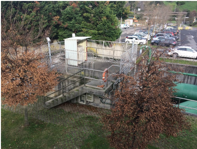
Lugar: EDAR GALINDO Edificio: I06 – Arqueta de agua tratada Comentario: Vista general.
