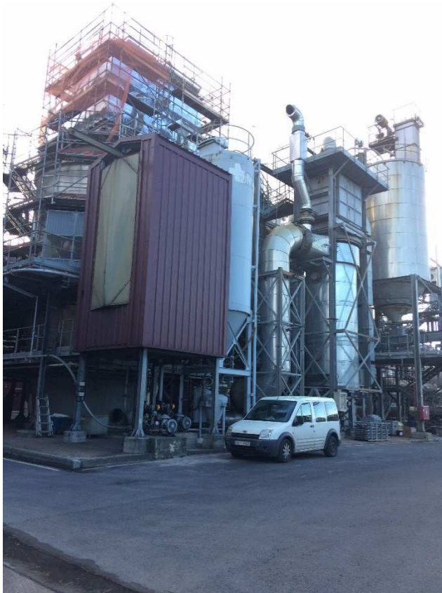
Lugar: EDAR GALINDO Edificio: I09 – Horno 2 Comentario: Vista general.
