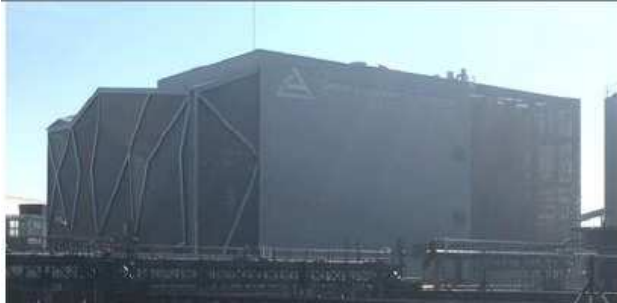
Lugar: EDAR GALINDO Edificio: I23 – Horno 3 Comentario: Vista general.
