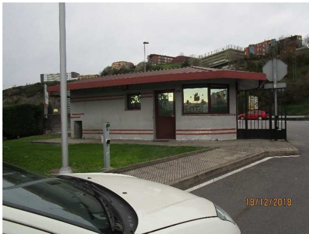
Lugar: EDAR GALINDO Edificio: E16 – Control de accesos Comentario: Vista general
