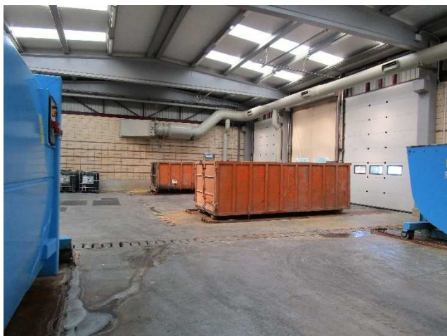
Lugar: EDAR GALINDO Edificio: E21 – Almacén de contenedores Comentario: Vista general del almacén
