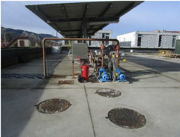
Lugar: EDAR GALINDO Edificio: I10 – Depósitos energía emergencia Comentario: Vista general del exterior.
