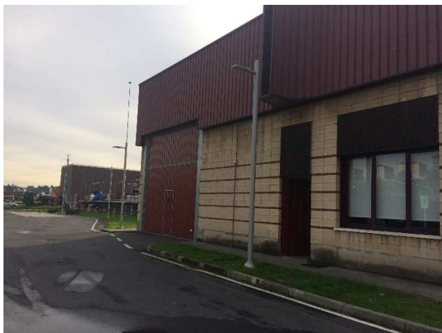
Lugar: EDAR GALINDO Edificio: E15 – Almacén y Vestuarios Comentario: Vista general
