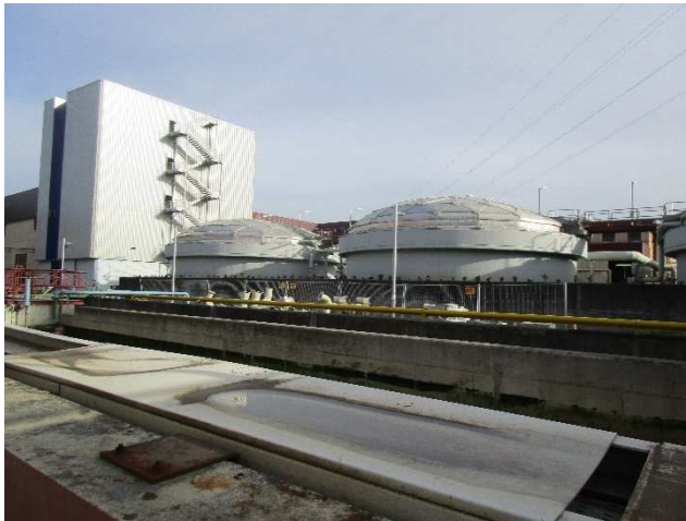
Lugar: EDAR GALINDO Edificio: I07 – Espesamiento de fangos Comentario: Vista general.
