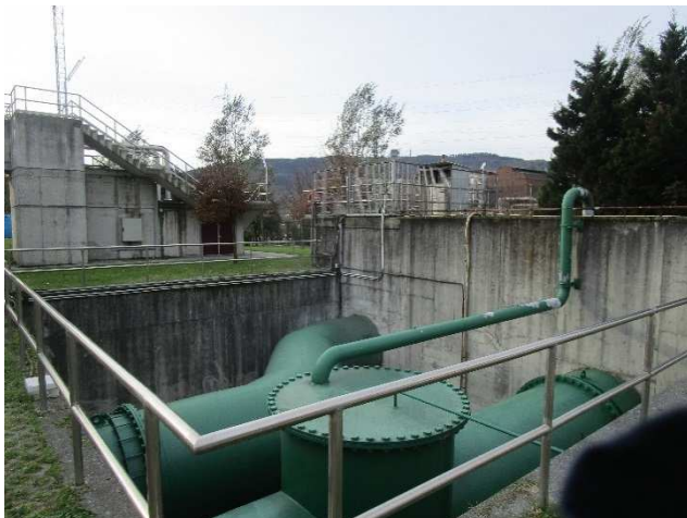
Lugar: EDAR GALINDO Edificio: I06 – Arqueta de agua tratada Comentario: Tuberías.
