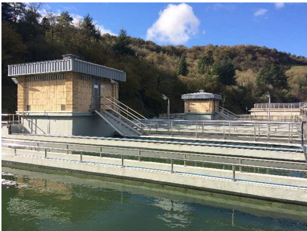
Lugar: ETAP VENTA ALTA Edificio: Nº10 - Decantadores fase I Comentario: Vista general.
