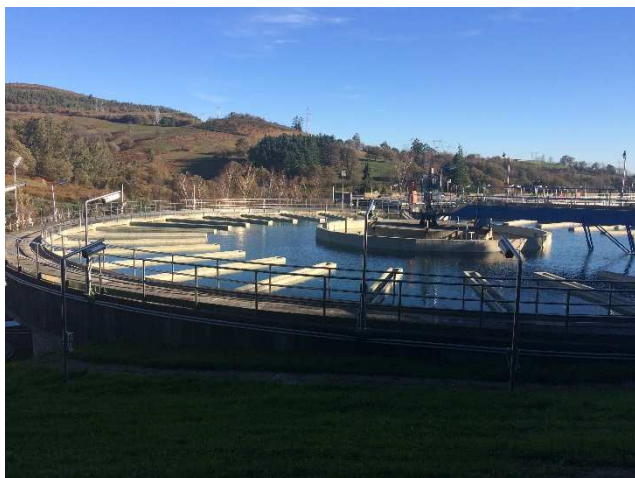
Lugar: ETAP VENTA ALTA Edificio: Nº19 - Decantadores fase II Comentario: Vista general de uno de los decantadores.
