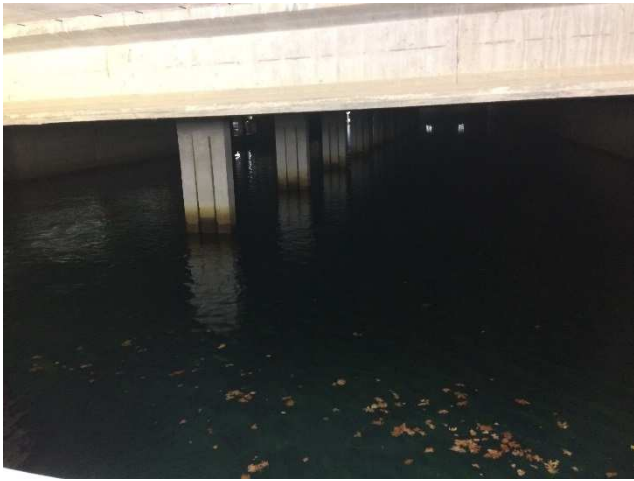
Lugar: ETAP VENTA ALTA Edificio: Nº30 - Antiguo depósito Comentario: Vista general.
