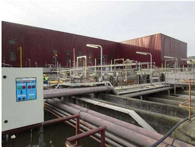
Lugar: EDAR GALINDO Edificio: I01 – Desarenado Comentario: Vista general.
