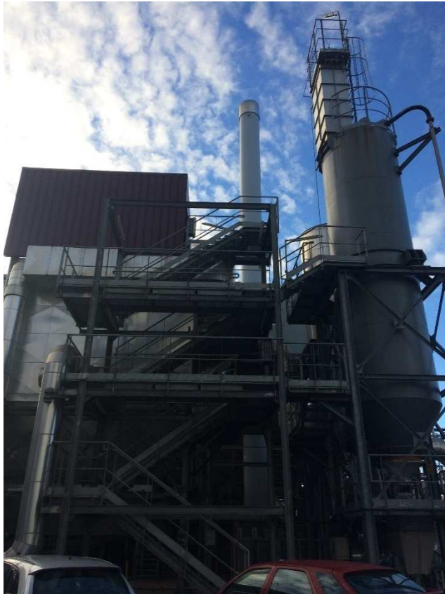
Lugar: EDAR GALINDO Edificio: I08 – Horno 1 Comentario: Vista general.
