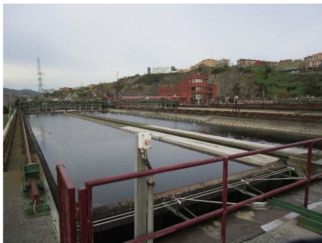
Lugar: EDAR GALINDO Edificio: I05 – Decantación secundaria Comentario: Vista general.
