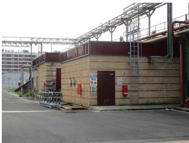
Lugar: EDAR GALINDO Edificio: E17 – Almacenamiento de sosa Comentario: Vista general
