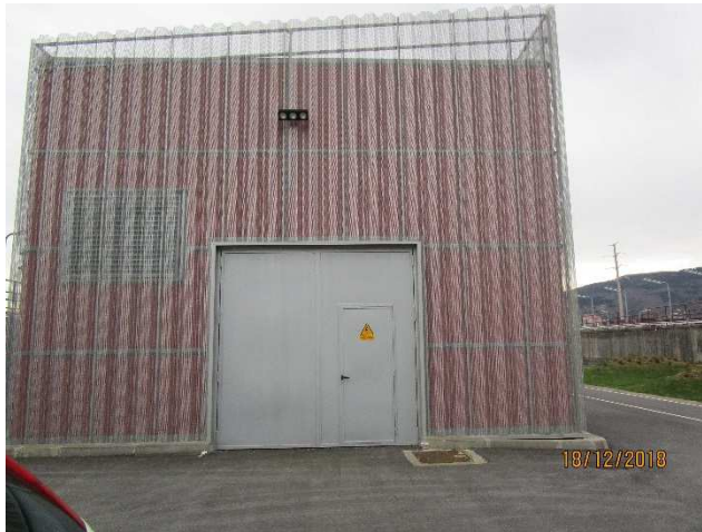
Lugar: EDAR GALINDO Edificio: E27 – CT Biológico Comentario: Vista general del edificio.
