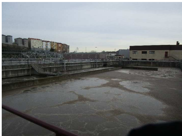
Lugar: EDAR GALINDO Edificio: I04 – Reactor biológico Comentario: Vista general.
