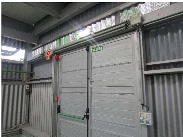
Lugar: EDAR GALINDO Edificio: E23 – Bombeo de agua tamizada Comentario: Pulsador y sirena junto a la salida señalizada.
