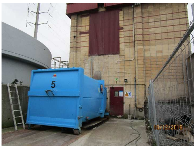
Lugar: EDAR GALINDO Edificio: E05 – Tamizado de Fangos Primarios Comentario: Vista general
