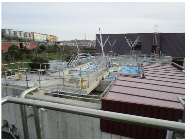
Lugar: EDAR GALINDO Edificio: I17 – Instalaciones de tratamiento terciario Comentario: Vista general.
