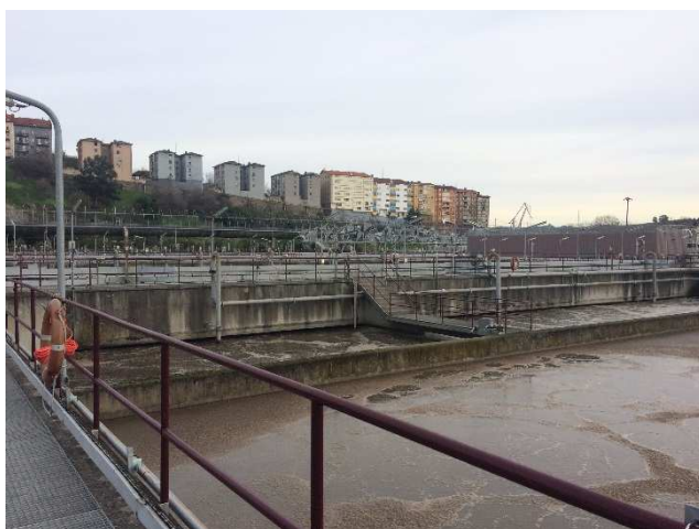
Lugar: EDAR GALINDO Edificio: I04 – Reactor biológico Comentario: Vista general de la piscina donde no se aprecian elementos contra incendios (incorrecto).
