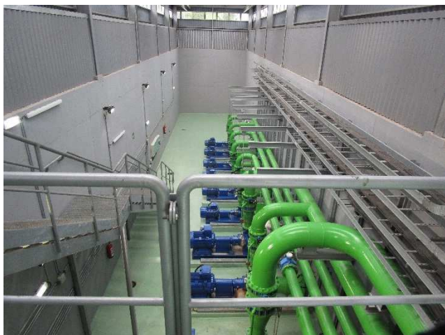
Lugar: EDAR GALINDO Edificio: E23 – Bombeo de agua tamizada Comentario: Vista general del edificio.
