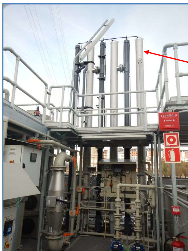
Fig. 18. Columnas Atmosféricas (Post-ozonización)
