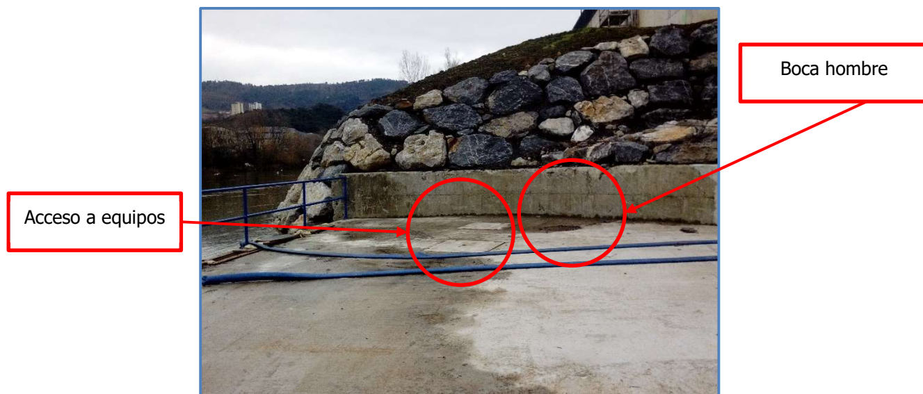
Fig. 4. Accesos al canal de captación
