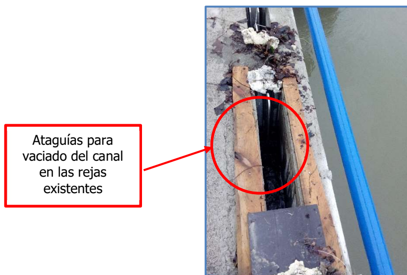
Fig. 5. Rejas existentes en canal de captación
