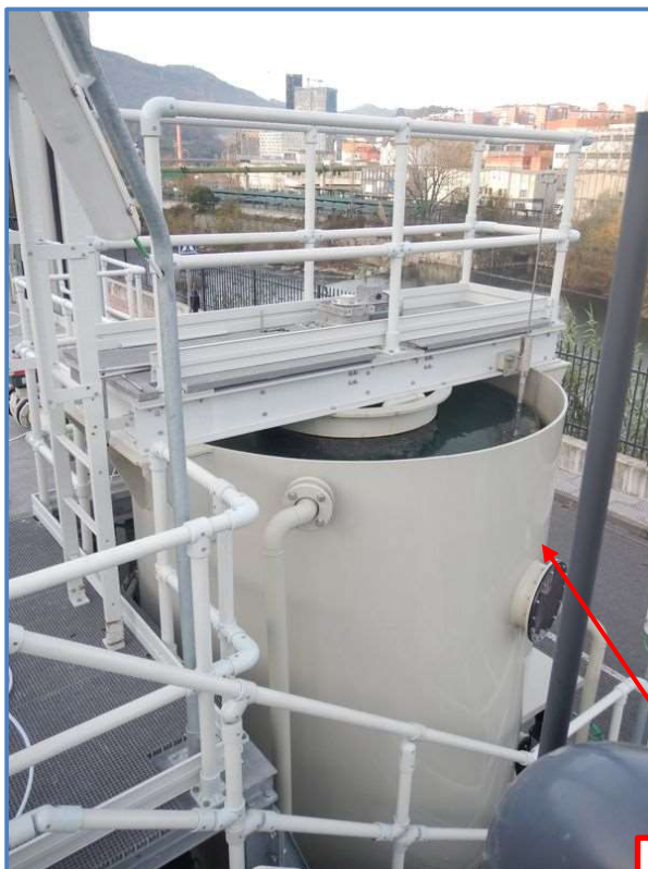
Fig. 13. Decantador Accentrifloc
