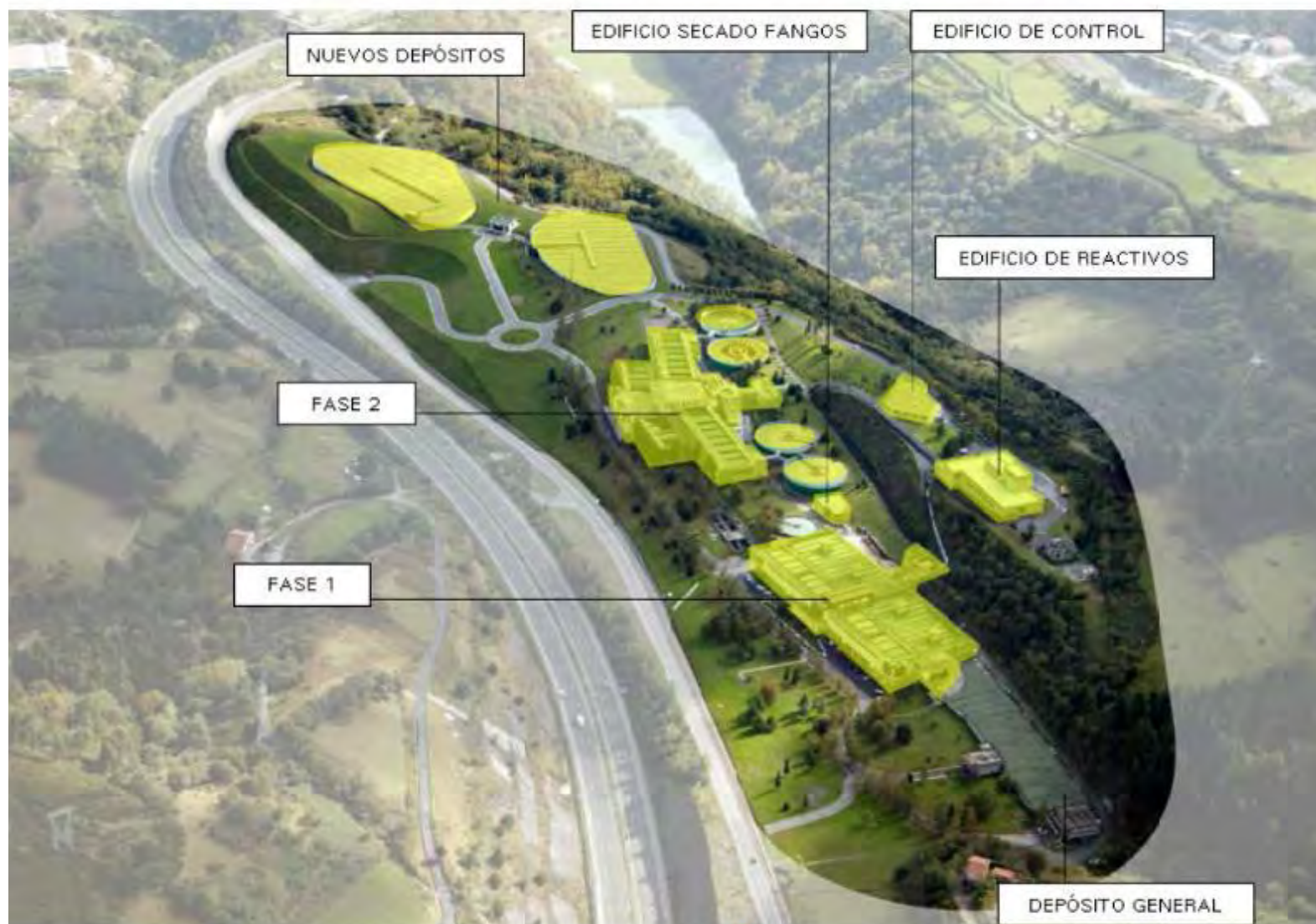
Vista general de la ETAP
