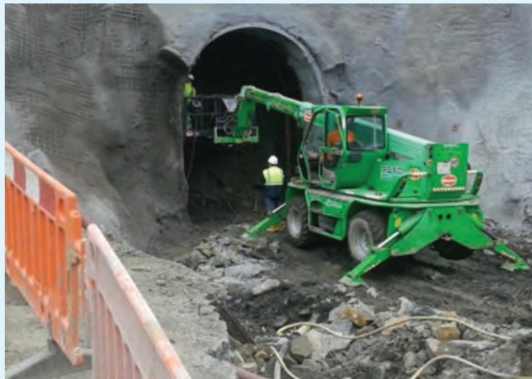
Replanto de barrenos en frente de excavación
