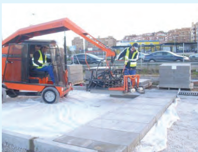
Equipos mecánicos para colocación de piezas de solado.
