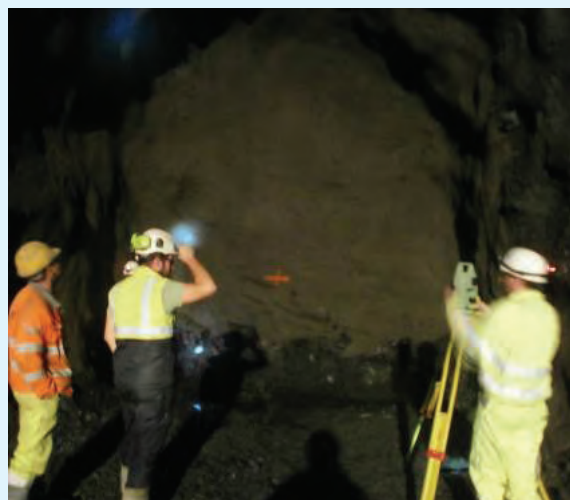
Replanto de barrenos en frente de excavación
