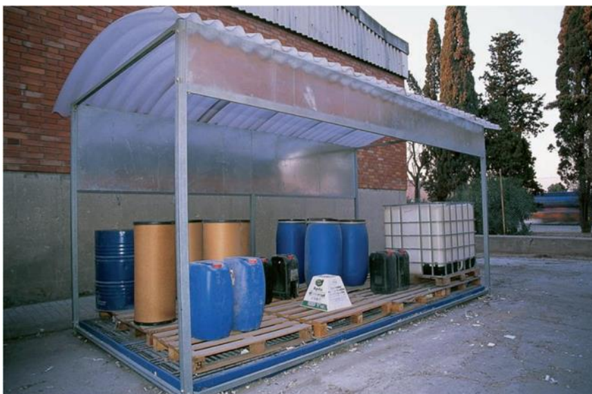
Ejemplo de Punto Limpio en construcción
