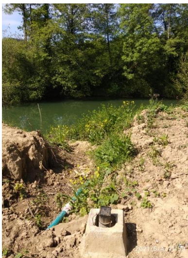
Paso río Butrón. VC Ø 150 mm, margen Mungia
