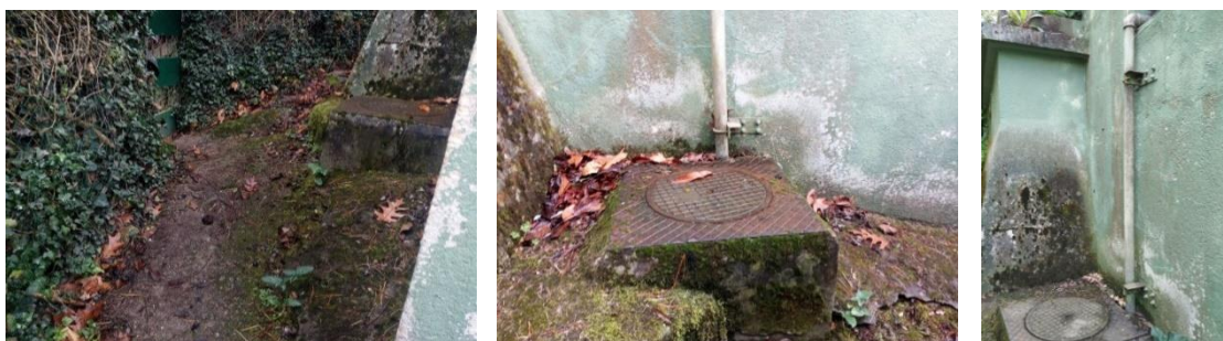
Arquetas anexas al depósito
