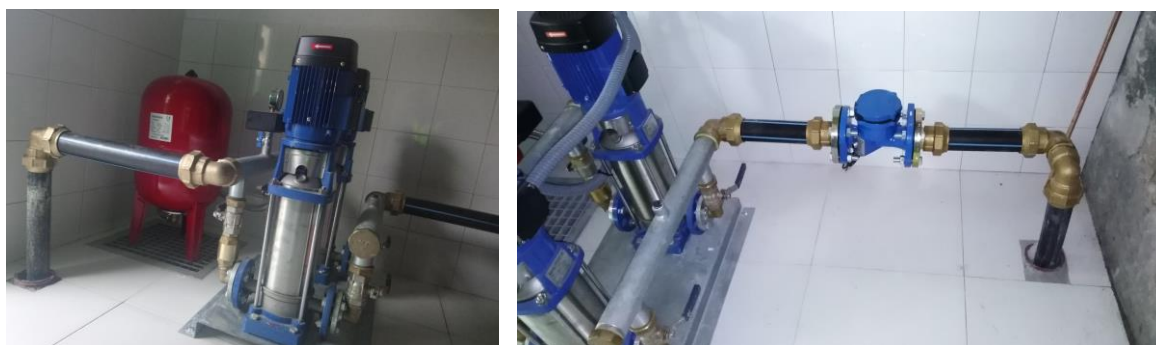
Interior caseta de bombeo.
