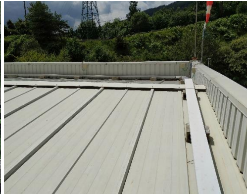
Estado de la cubierta reformada
