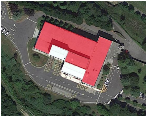
Área de cubierta a reformar
