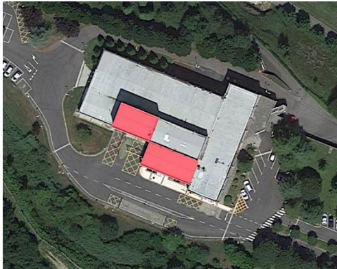
Área de cubiertas ya reformadas
