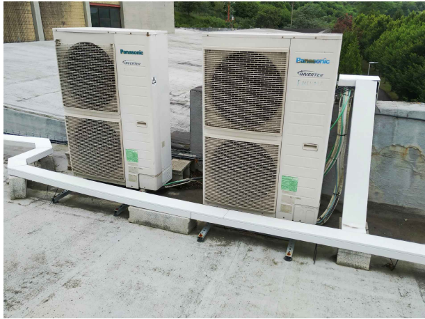
TENDIDOS ELÉCTRICOS EN CANALETA Y EQUIPOS DE INSTALACIONES DIVERSOS APOYADOS O FIJADOS A PETO Y/O CUBIERTA
