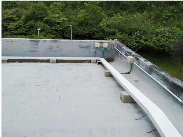
TENDIDOS ELÉCTRICOS EN CANALETA Y EQUIPOS DE INSTALACIONES DIVERSOS APOYADOS O FIJADOS A PETO Y/O CUBIERTA
