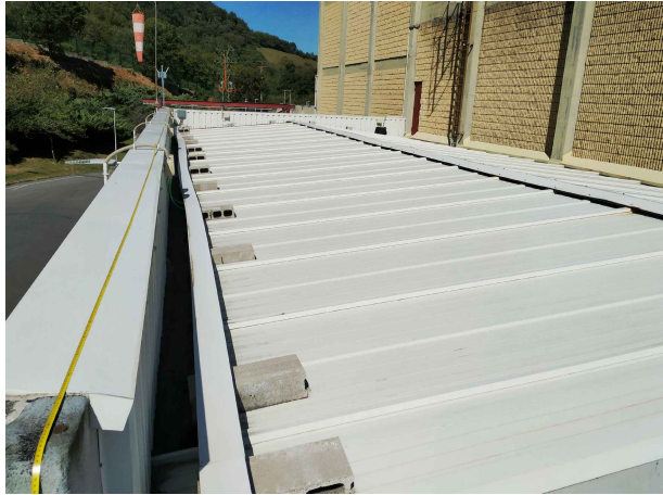
CUBIERTA REFORMADA CON PANEL SANDWICH. NO SE INTERVIENE EN ESTA ZONA
