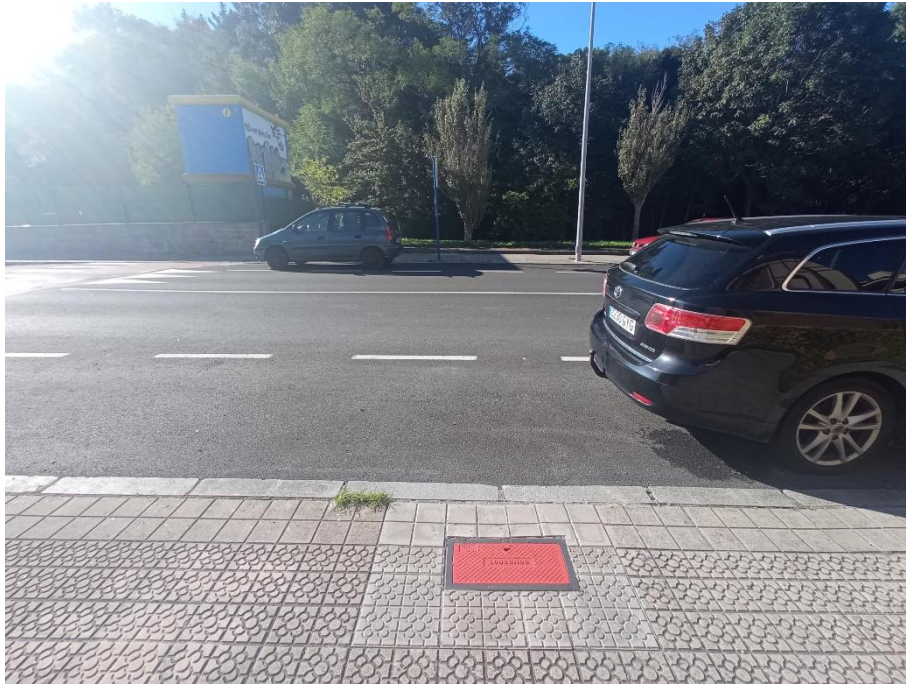
Punto de conexión a red existente CRE3
