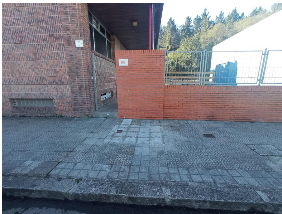
Punto de conexión a red existente CRE4
