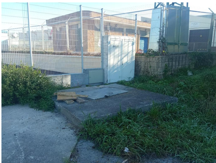
Arqueta en el exterior de la Sala de válvulas de Larragoiti
