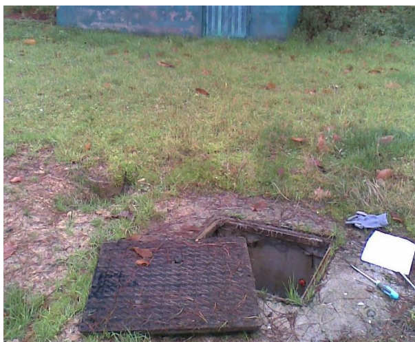
Arqueta de válvulas depósito de Lamindao
