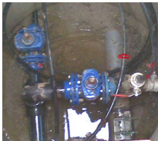
Arqueta de válvulas depósito de Lamindao
