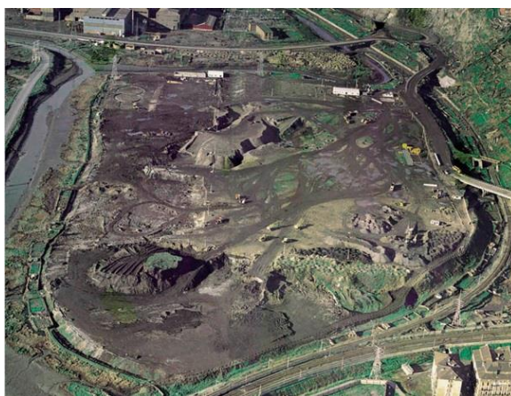
Año 1985: comienzo de las obras
