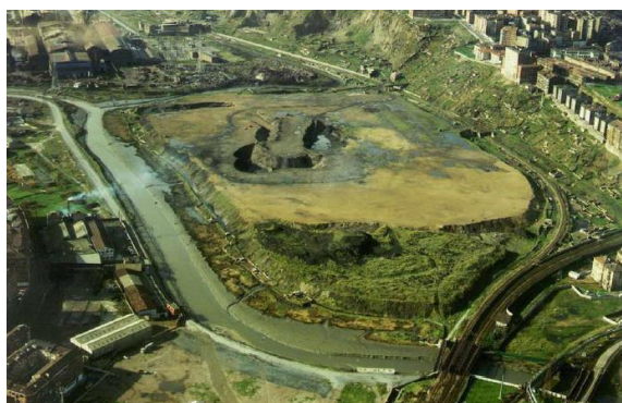
Año 1973: estado inicial del terreno
