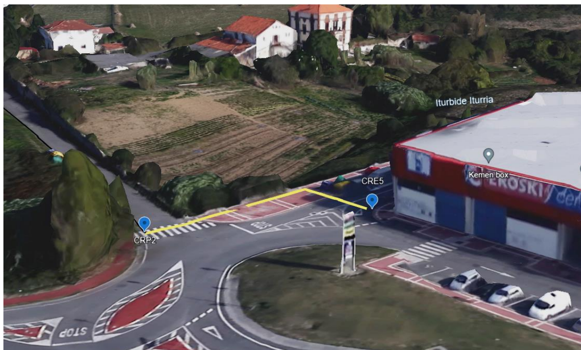
Conexión de la red procedente de la arqueta derivación Gentilmendi y la tubería a ejecutar en otra fase
