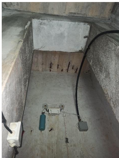
Patologías de armadura vista en la sala de llaves
