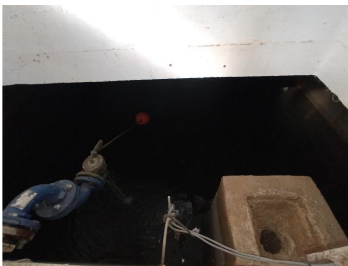
Llenado del cuenco y rebosadero de hormigón
