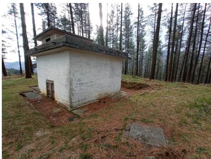
Desagüe y arqueta desagüe junto al deposito
