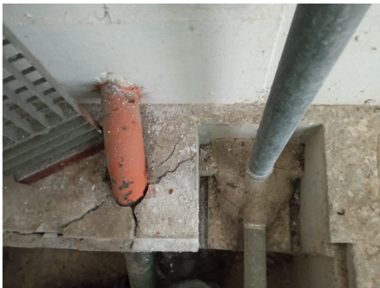
Tuberías de llenado y distribución
