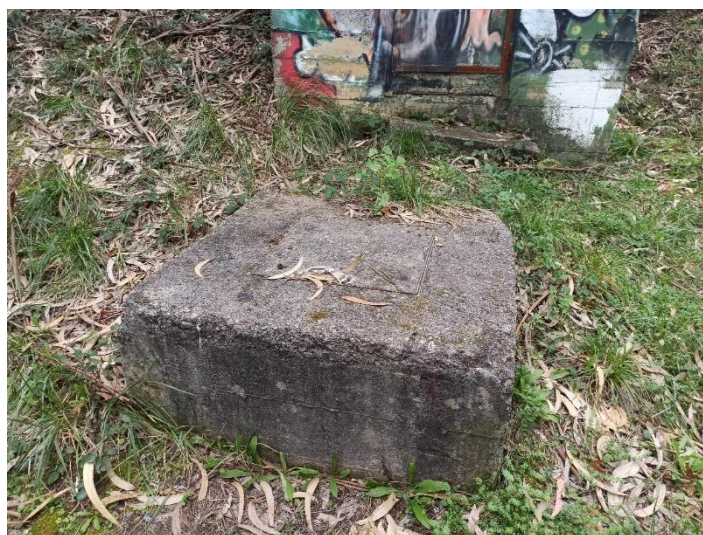
Arqueta desagüe en el exterior del depósito
