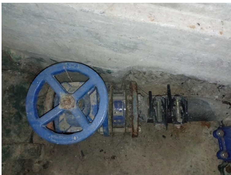
By-pass y válvula antirretorno
