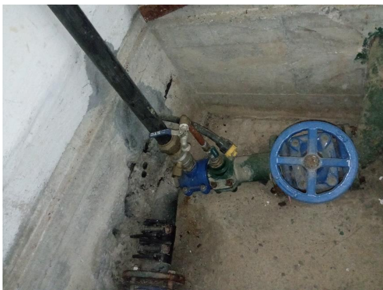
By-pass provisional y grifo toma-muestras
