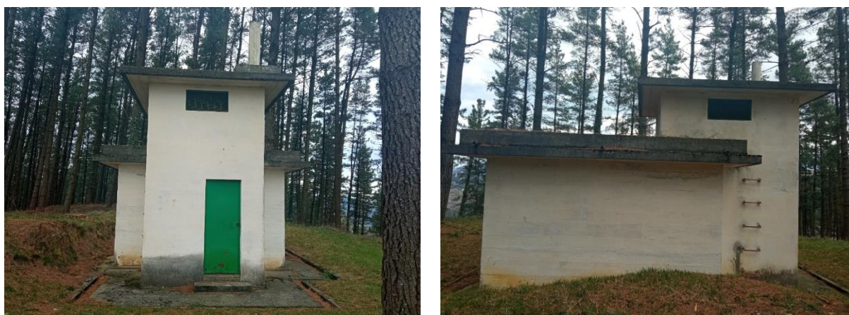
Fachada del depósito
