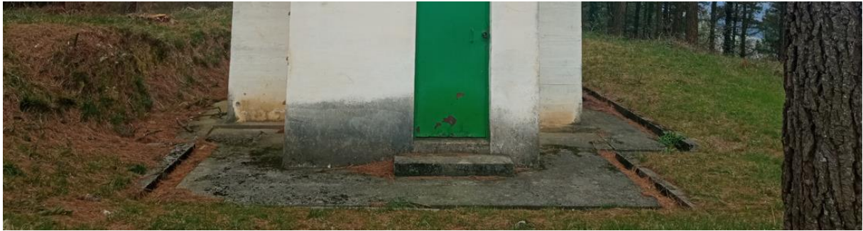
Pasillo perimetral existente
