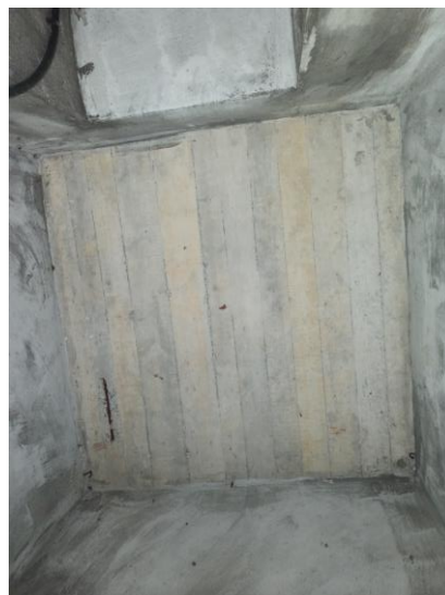
Patologías de armadura vista en la sala de llaves
