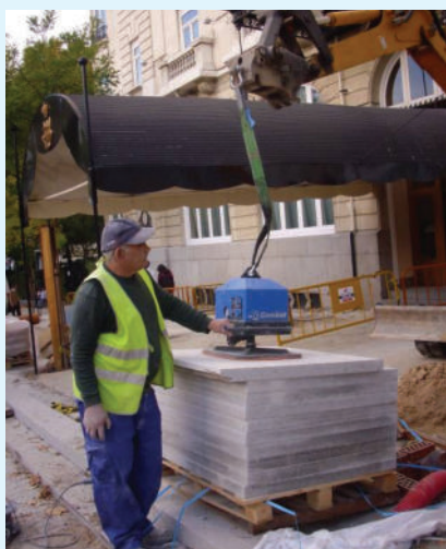
Equipos mecánicos para colocación de piezas de solado.
