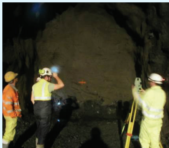
Replanto de barrenos en frente de excavación
