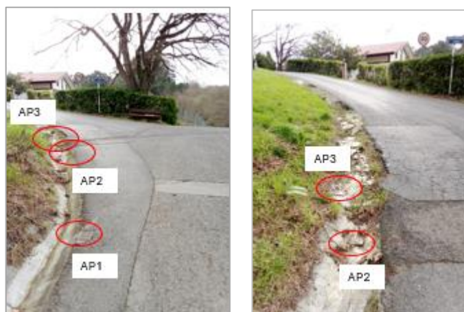
Conexión a la Red existente (CRE). Punto inicial de la renovación.
