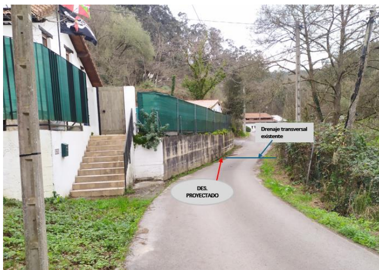
Emplazamiento desagüe proyectado a drenaje transversal existente.
