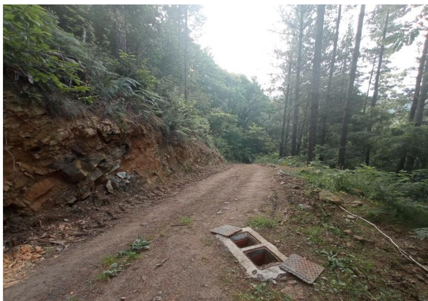
Punto de conexión a red existente (CRE1)
