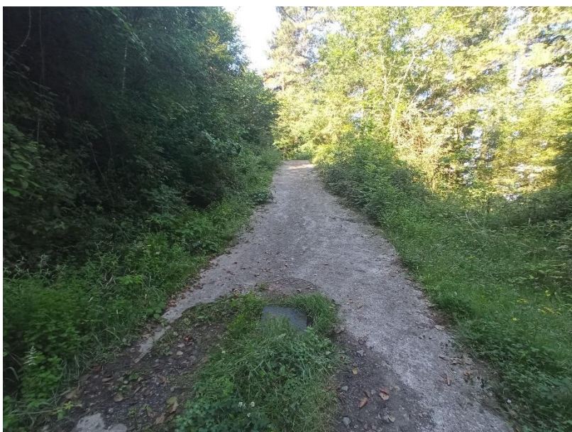
Arquetas existentes (CRE7)
