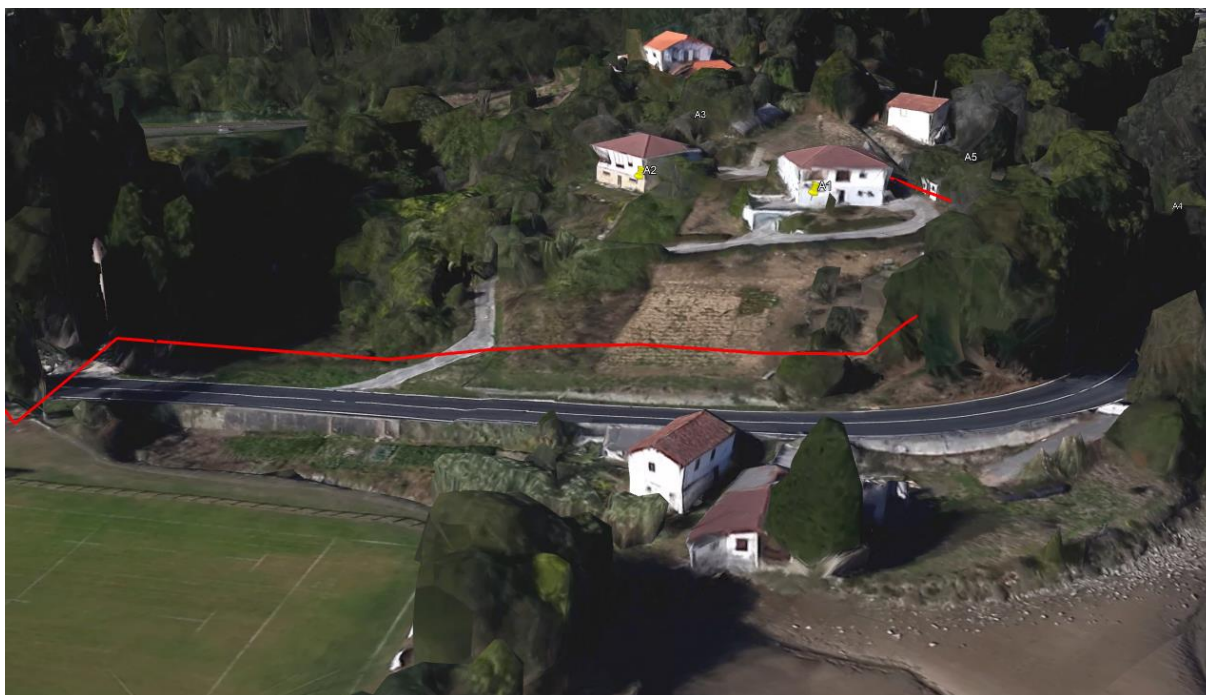
Trazado de la tubería por detrás de la línea de servicios generales de la BI-2704
