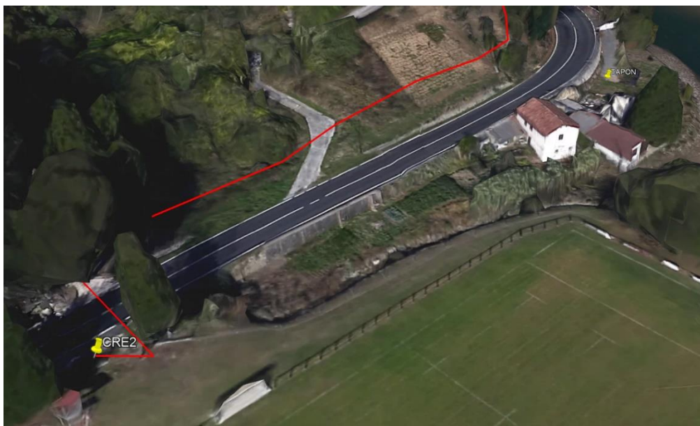
Situación de la conexión a red existente CRE2 y el tapón junto a la vivienda en Ardantza
