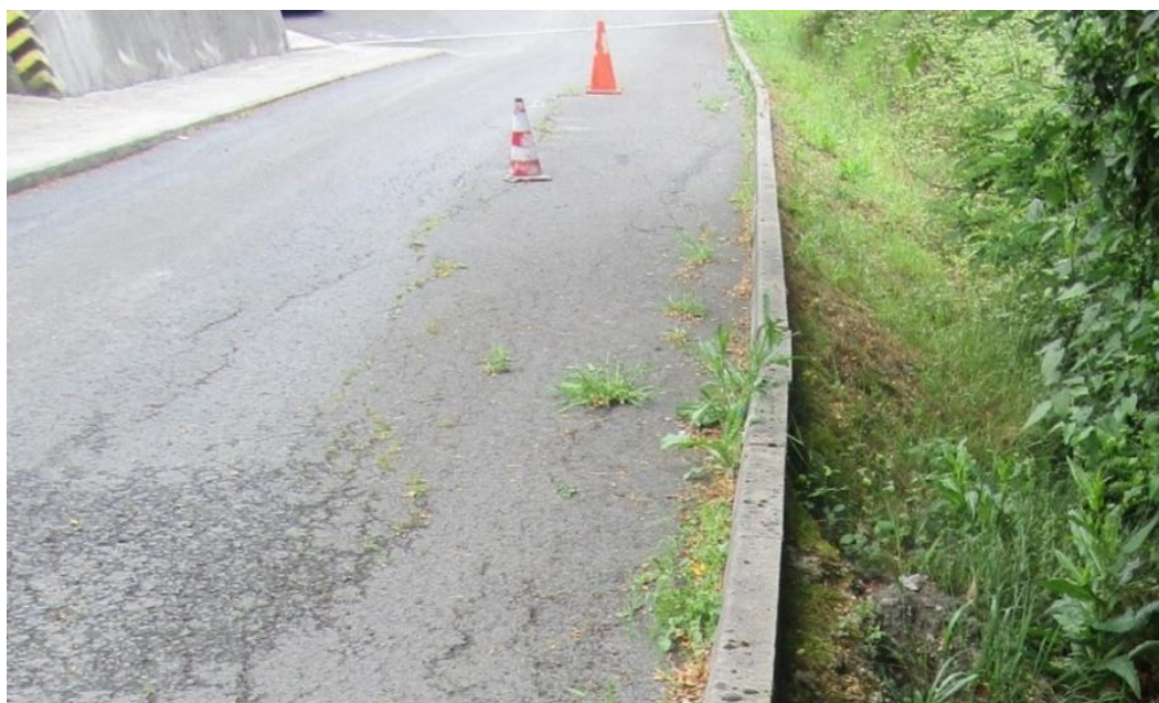
Figura 1.5. Rampa de acceso del Centro de Interpretación Ambiental de Artigas.
