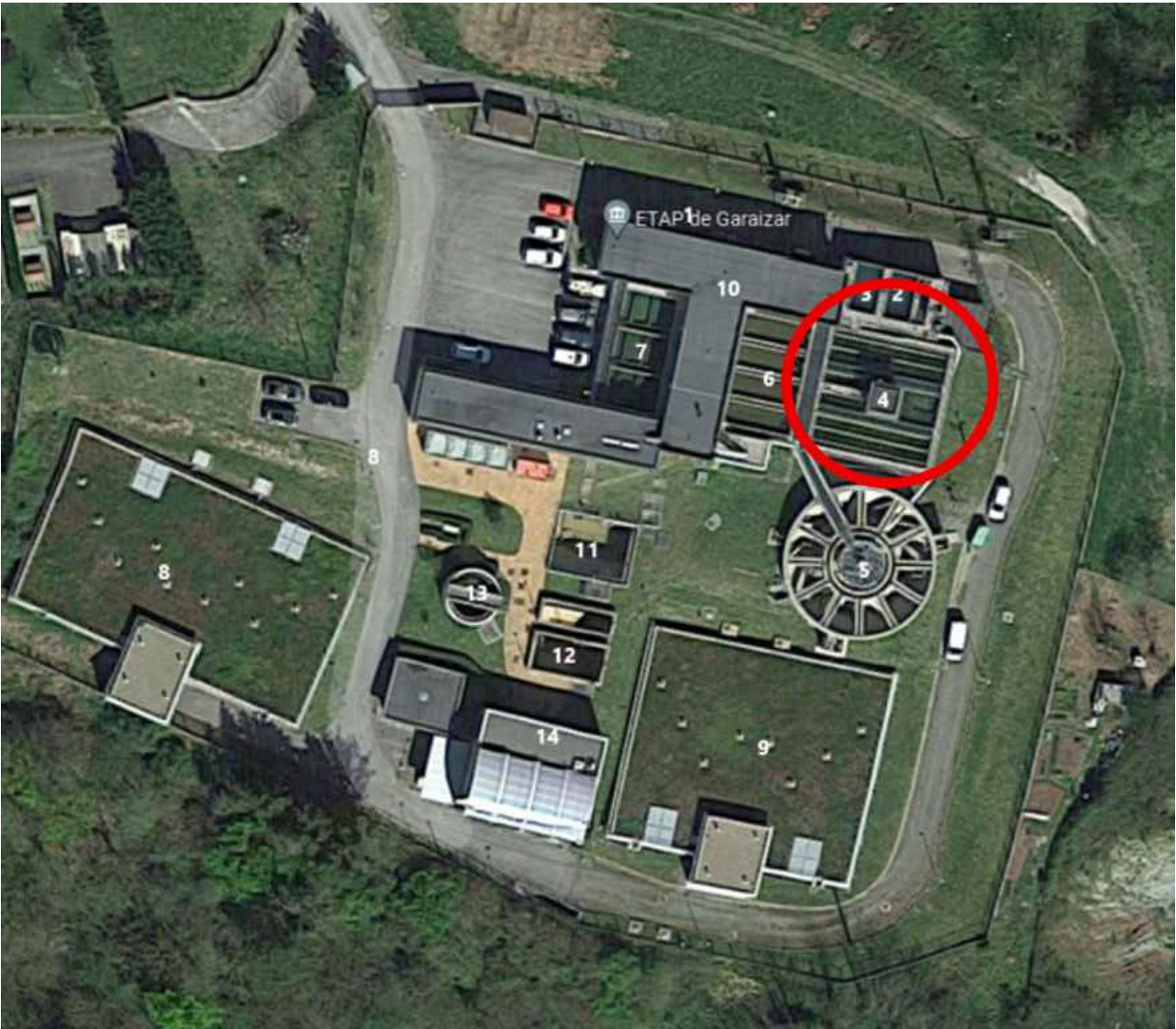
Situación de la obra en la propia ETAP
