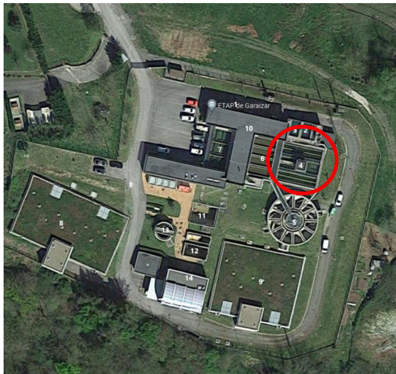
Localización de la zona de trabajos en el interior de la ETAP
