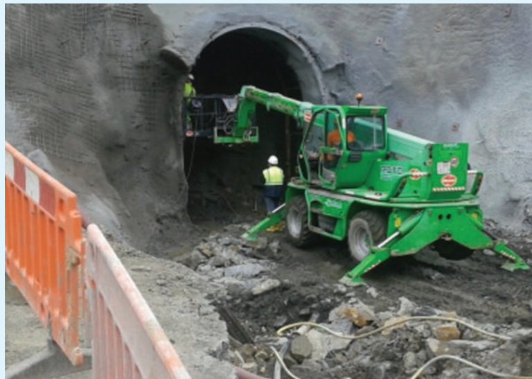
Replanto de barrenos en frente de excavación
