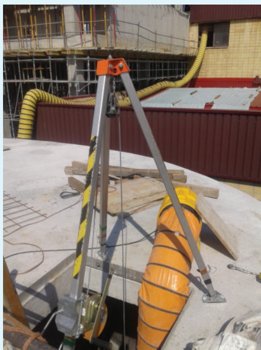
Acceso con trípode rescatador y ventilación forzada
