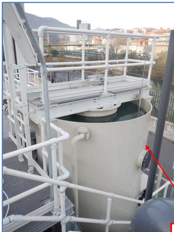
Fig. 13. Decantador Accentrifloc
