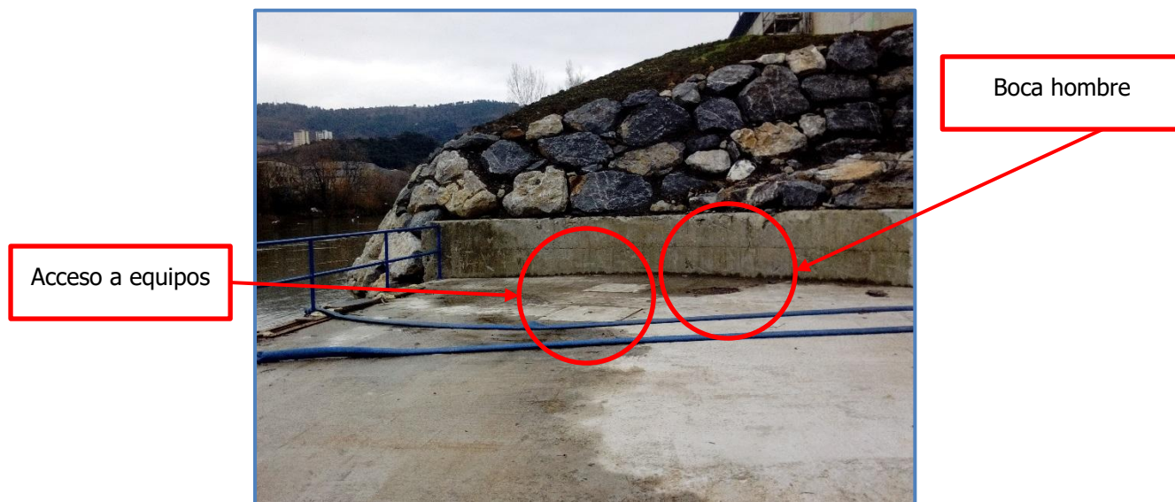
Fig. 4. Accesos al canal de captación
