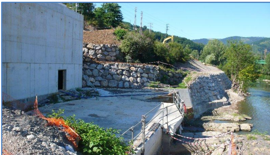
Fig. 3. Captación del río Nervión
