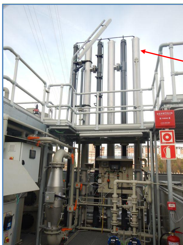
Fig. 18. Columnas Atmosféricas (Post-ozonización)
