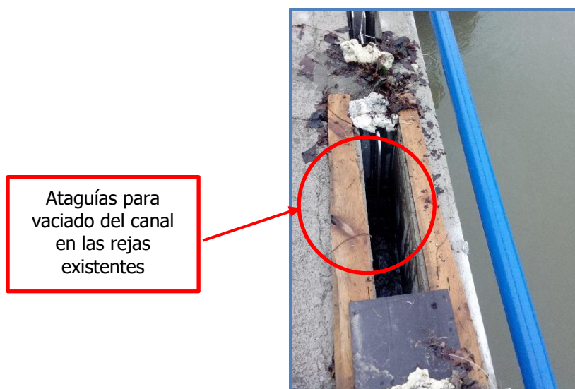
Fig. 5. Rejas existentes en canal de captación
