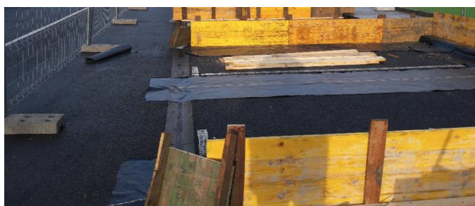
Fig: 17 - Imagen de la construcción de las bancadas en la ubicación actual
