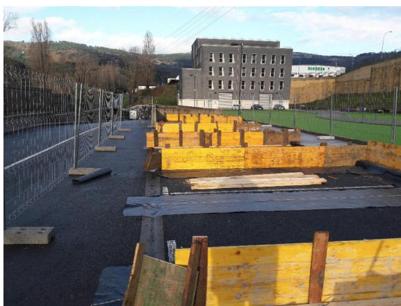
Fig: 14 - Imagen de la construcción de las bancadas en la ubicación actual
