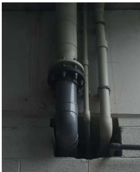
Fig: 24 - Imagen del cambio de material en la tubería de vertidos
