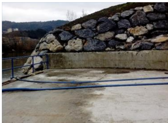
Fig: 4 - Vista del forjado superior del canal de la obra de toma del turbinado y bombeo
