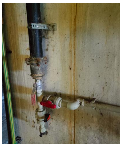
Fig: 9 - Imagen del picaje de agua potable para la planta piloto
